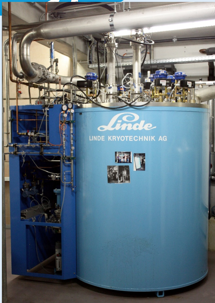
Ожижитель водорода Linde на гелиевом внешнем цикле производительностью 20 кг/ч
